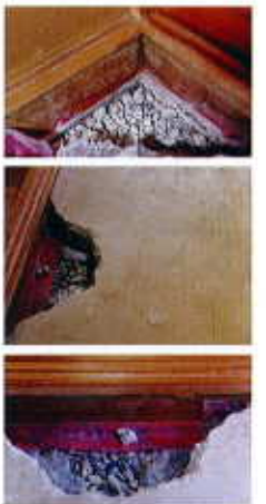
●築20年後の床下 砂利層、コンクリート、木土台は乾燥しています。
